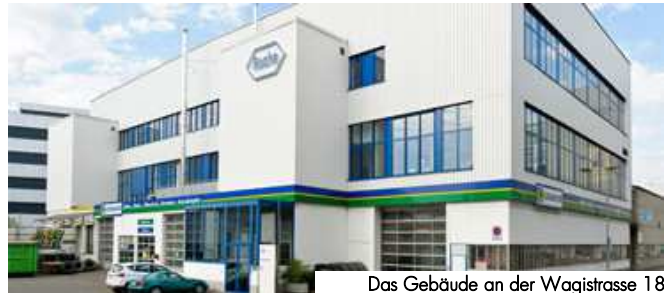
Das Gebäude an der Wagistrasse 18
